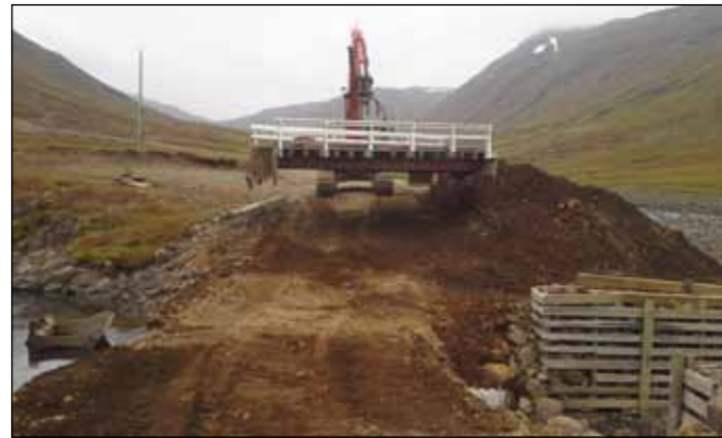
Yfirbygging flutt á brott og lögð til hliðar.
